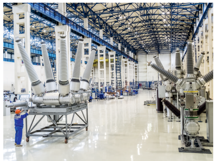
Цех сборки высоковольтной аппаратуры
