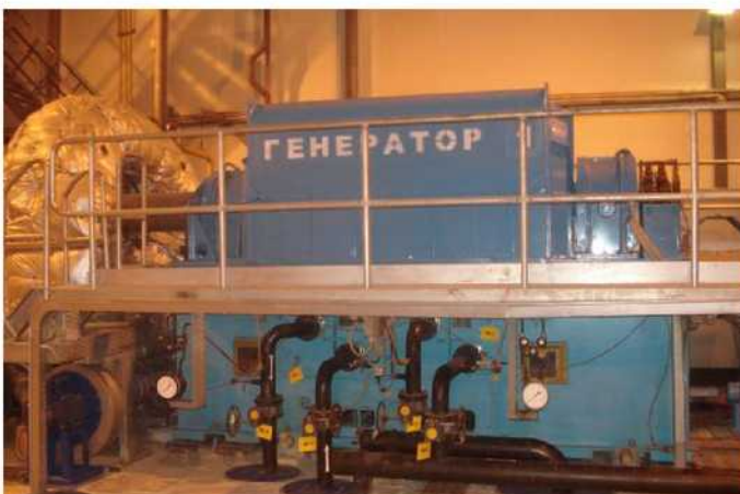
Турбогенератор ТФЭ-10-2(3x2)/6000У3 на магнитных подшипниках 10000 кВт, 3 кВ, 6000 об/мин
